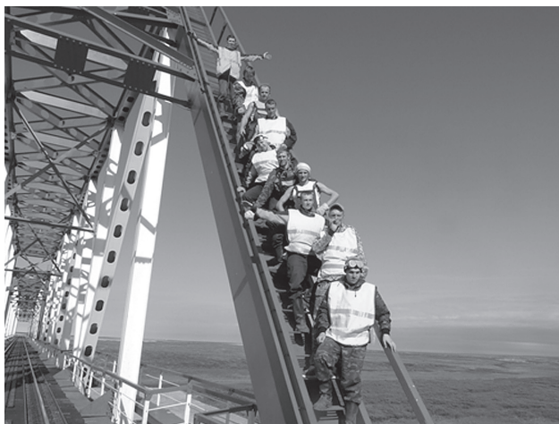
Рис. 3. Студенческий строительный отряд «Ямал», мост через Юрибей
