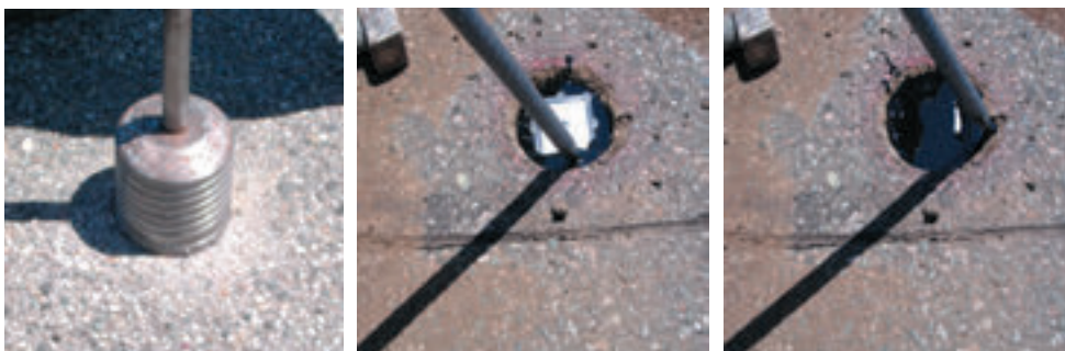
Рис. 49. Пример подготовки узла сети датчиков и установки магнитометра (источник: ТСК г.Турина – Политехнический университет Турина)
