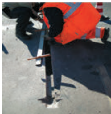
Рис. 46. Пьезоэлектрический датчик (источники: Kistler и Политехнический университет Турина)
