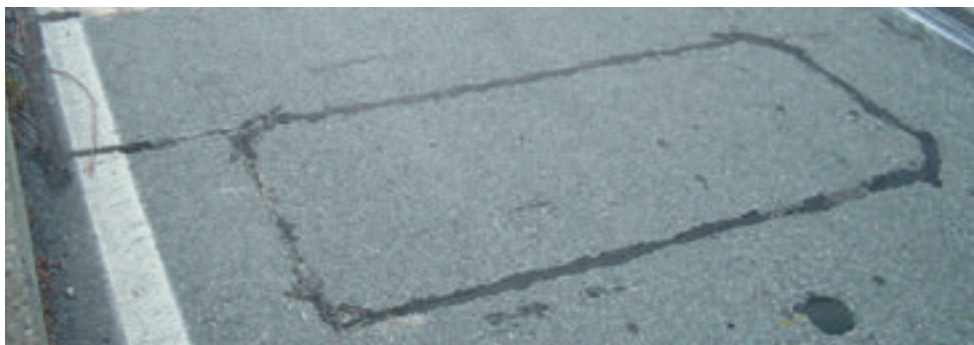
Рис. 44. Магнитные датчики: примерная схема расположения «узла» сети магнитных датчиков (темный круг в правом нижнем углу) и проводника индуктивного датчика (центральная часть фото)
