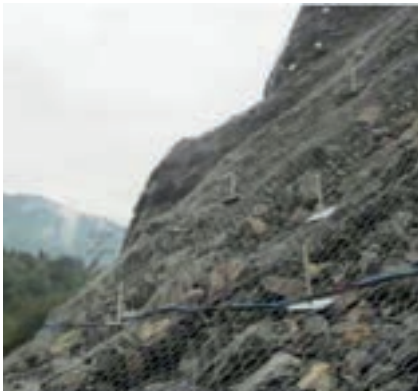
Крепление откосов сетчатым полотном, строение
