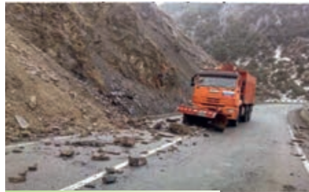
Сползание недостаточно спланированного верхового откоса
