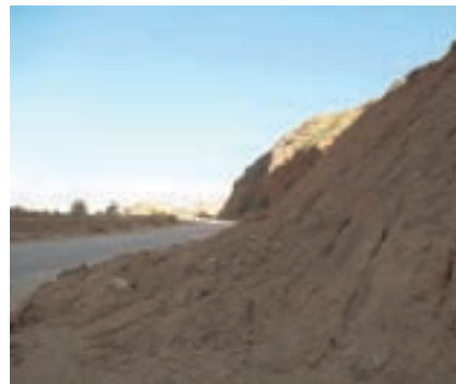
Сползание грунтовой массы (участок без подпорной стенки)
