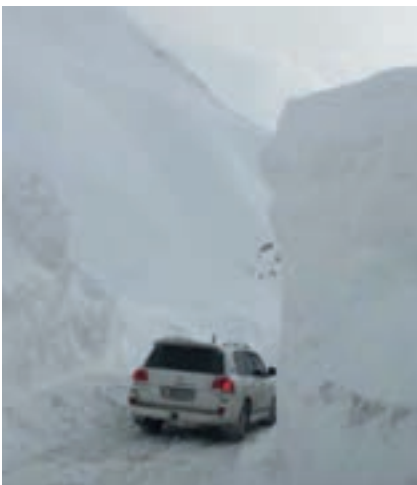
Участок горной дороги после схода лавины
