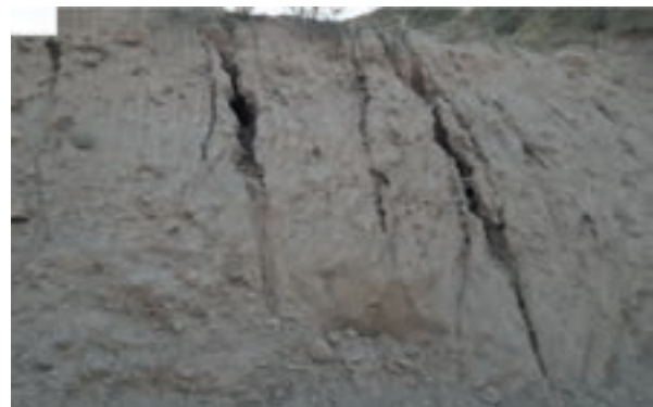
Разрушение откосов вследствие интенсивных осадков
