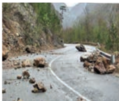
Сползание недостаточно спланированного верхового откоса на участке автодороги Душанбе-Худжанд (пос. Айни)
