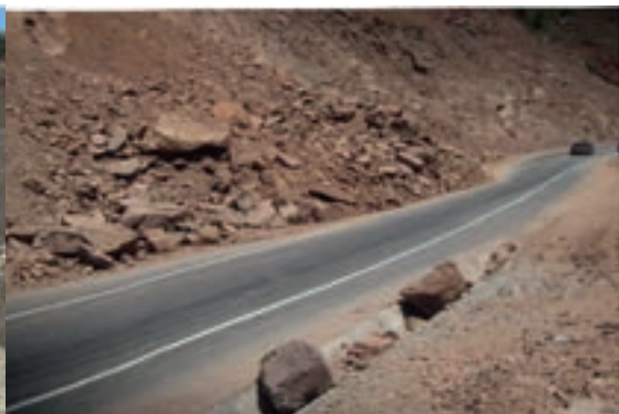
Сползание недостаточно спланированного верхового откоса
