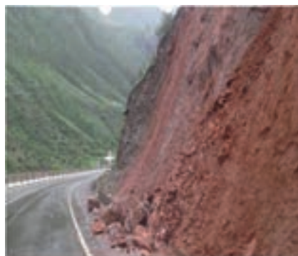
Сползание недостаточно спланированного верхового откоса на участке автодороги Душанбе-Худжанд (пос. Айни)
