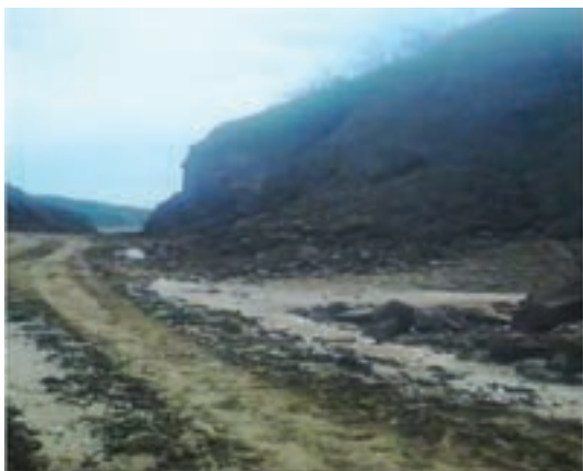
Сползание недостаточно спланированного верхового откоса на участках автодороги Балджувон Сари-Хосор
