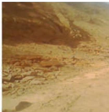
Сползание недостаточно спланированного верхового откоса на участках автодороги Балджувон Сари-Хосор
